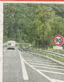
En 2019, le viaduc de Brion avait l'objet de travaux.
